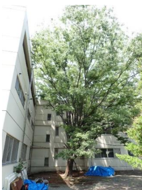
倒れる前の状況 長期間無剪定で枝葉繁茂し、枯枝は多かったが、元気そうであった
