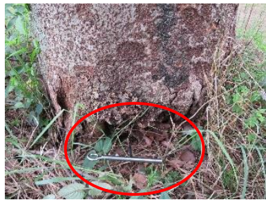
※鋼棒が根元にスボスボ貫入した
