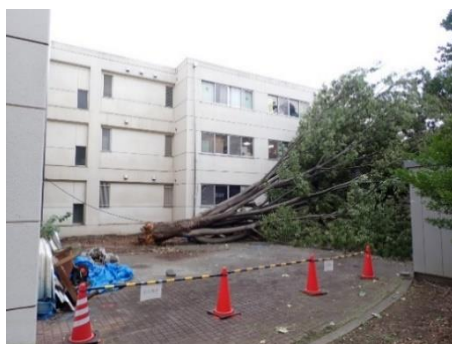
風向きなどにより、倒れる方向は変わってくるが、今回建物のガラス等が割れなかった
